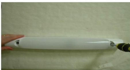
Fixer à travers l'applique et tester l'allumage.
