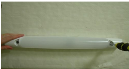
Fixer à travers l'applique et tester l'allumage.
